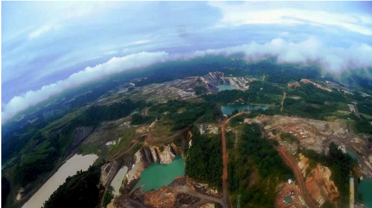
Gambar.1. lahan bekas penambangan terbuka (Open Pit) Sumber: Jatam Kaltim
